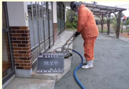
住宅の除染(山田岡地区) 2013年7月8日
