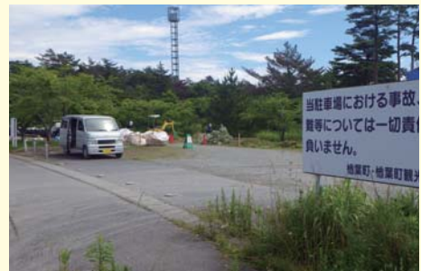
駐車場の除染(山田浜地区) 2013年7月8日
