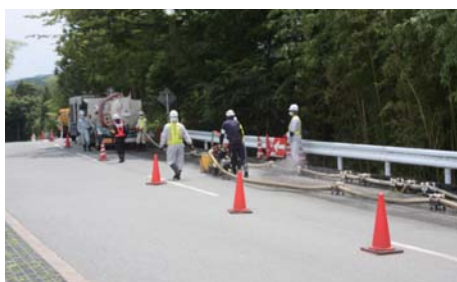
道路の除染(上繁岡地区) 2013年7月12日
