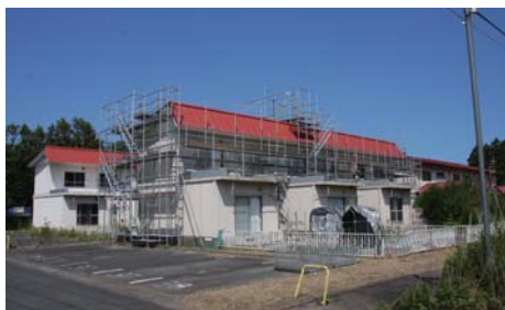
町営住宅の除染(向ノ内団地) 2013年7月8日
