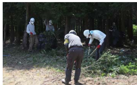
住宅裏庭の除染(営団地区) 2013年7月10日
