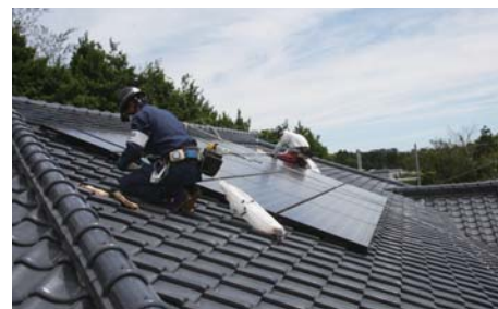
屋根の除染(上小埜地区) 2013年7月19日 瓦屋根は瓦を1枚1枚拭き取りにより除染を行います。
