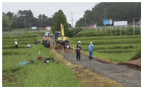
農地の除染(繁岡地区) 2013年7月24日 畦道の除染を行っています。畦道は除草を行い、5cm程度の剥ぎ取りを行います。その後、土地に客土を行い畦道を築立し、法面を仕上げ、元の現況高まで復旧します。
