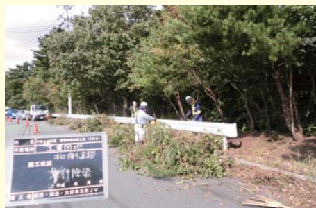
道路の除染(山田岡地区) 2013年9月23日
