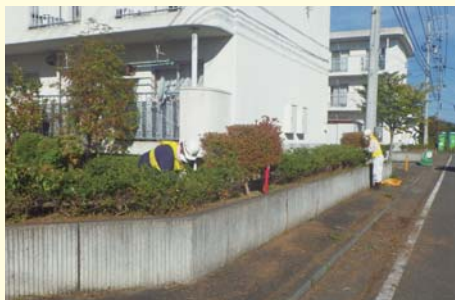
町営住宅の除染(山田岡地区)
