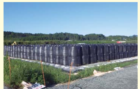
下井出地区仮置場 2013年9月17日
