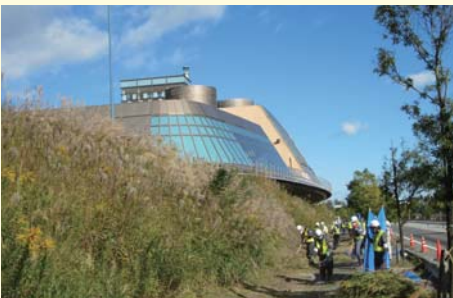
道路の除染 2013年11月13日
