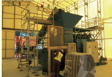
北田地区仮置場
