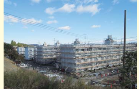
町営住宅の除染(山田岡地区)
