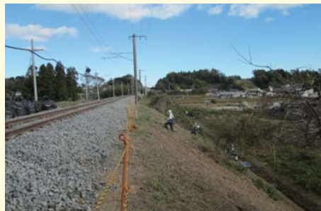
JR線路脇法面の除染(北田地区)
