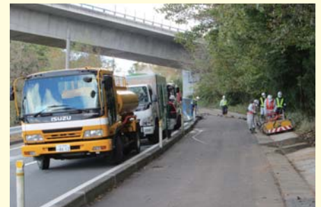
道路の除染(上井出地区) 2013年11月13日
