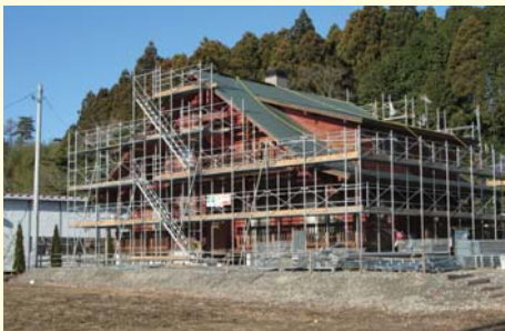
住宅の除染(山田岡地区) 2014年1月8日 安全を考慮し、足場を設置し拭き取りを中心とした除染を引き続き行っています。
