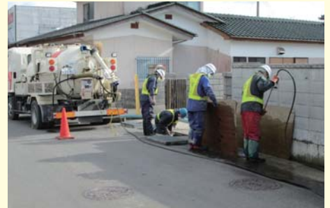
道路側溝の除染(上井出地区) 2014年1月6日 道路側溝の堆積物を除去し、高圧洗浄機にて除染を行います。また、排出した水は全てバキューム車にて回収し濁水処理施設にて処理を行っています。
