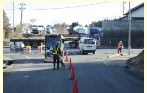
道路の除染(北田地区・山田岡地区) 2014年1月8日 道路は高圧水洗浄車で除染を行い、排水は全て吸引回収します。回収した排水は濁水処理施設に運搬後、放射性セシウムを除去します。
