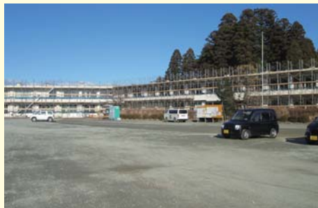
学校の除染(上井出地区) 2014年1月8日 櫛葉北小学校の除染を引き続き行っています。全面に足場を設置し、一般住宅同様拭き取りを中心とした除染を行います。
