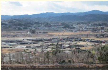
仮置場(前原地区) 2014年1月6日 除染作業にて発生した草や堆積物などを大型土のうに袋詰めし、仮置場に集積しています。
