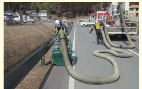
道路側溝の除染(山田岡地区) 2014年3月4日
