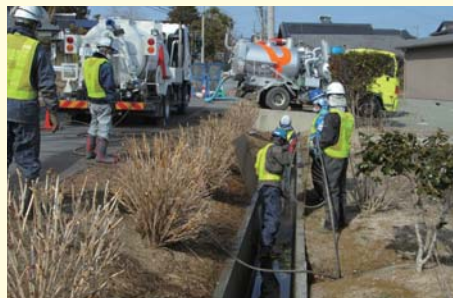
道路側溝の除染(山田岡地区) 2014年3月4日
