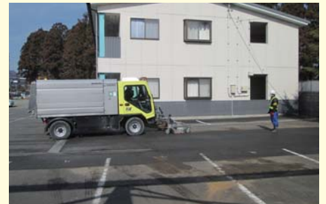
住宅の除染(下井出地区)
