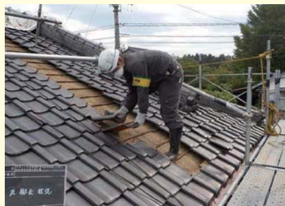
①解体家屋の屋根瓦を撤去しています。
