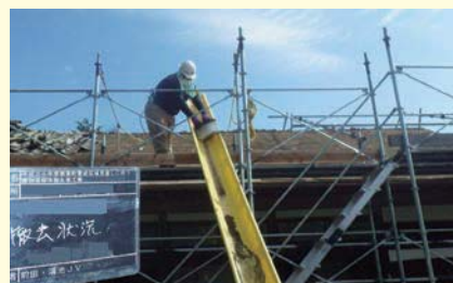
②撤去した瓦を安全に荷積みしています。
