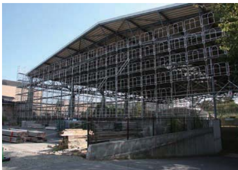
雨天練習場の除染を行うために足場を組み立てました。
