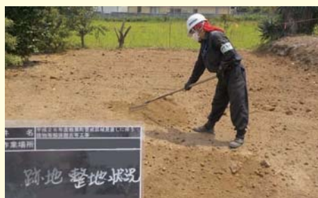
家屋解体後の整地状況 家屋解体後の跡地を丁寧に整地しています。
