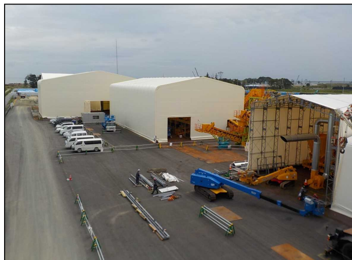
■仮設テント設置状況(前原A地区) 2016年10月1日 撮影
