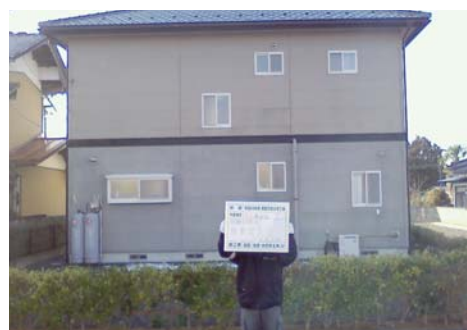
<施工後 2013年1月25日>
