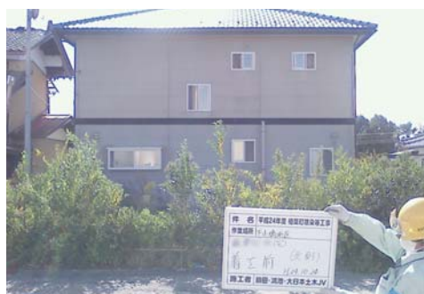
<施工前 2012年10月24日>
