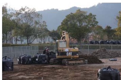
除染工事中:2012年12月12日
