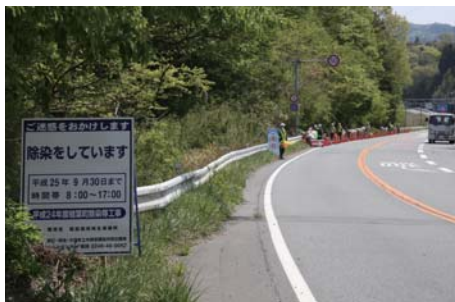
国道6号線の除染 2013年5月9日
