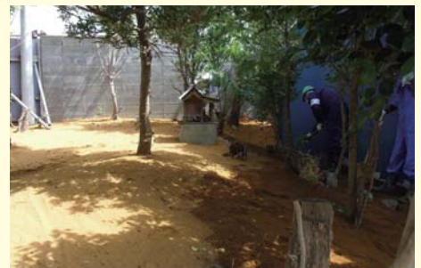
庭の除染(上井出地区) 2013年5月10日
