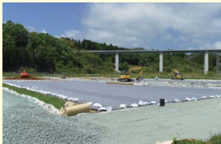
上井出地区仮置場 2013年5月30日 重機等により砂利・碎石を敷き均しています。
