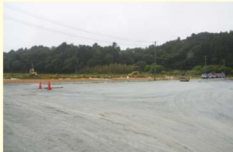
山田岡地区仮置場 2013年6月11日 重機等により砂利・碎石を敷き均しています。
