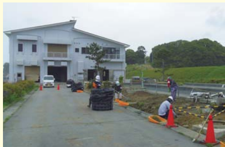
南浄化センター(山田浜地区) 2013年5月30日 舗装面、未舗装面、芝、側溝などそれぞれに合った除染方法を用いています。
