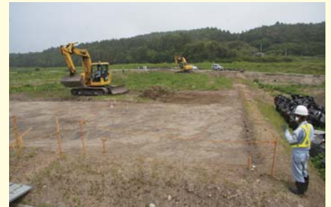
下井出地区仮置場 2013年6月11日 除草し重機等により堆積物を除去した後、整地 工事を行います。
