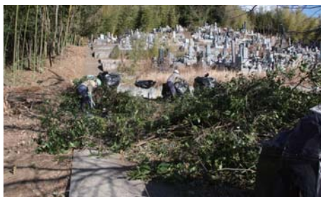
①敷地内の除草・常緑樹の枝払い・堆積物を除去します。
