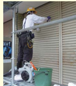
商店の除染(山田岡地区) 2013年5月30日 拭き取りによる除染を行っています。シャッターの溝の1つ1つも拭き取りにより丁寧に除染します。
