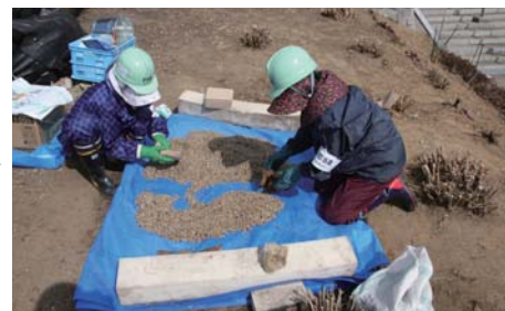
③砂利・碎石は深さ5cm程度の入れ替えを行います。同等品の入替えが難しい場合には洗浄することにより除染します。
